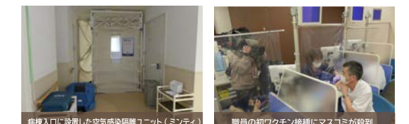
病棟入口に設置した空気感染隔離ユニット（ミニティ）
