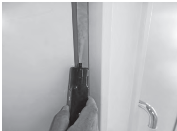
写真3：スモークジェネレーターチェック
