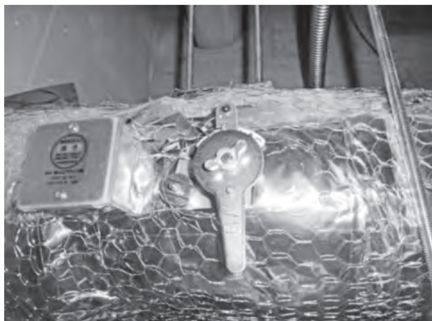
写真1: 給気ダンパー (FVD)
