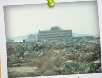
大津波で全壊した 岩手県立高田病院
