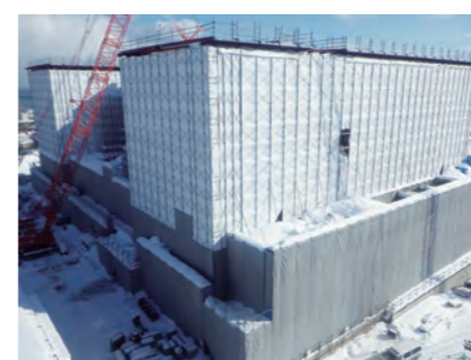
【平成 26 年 1 月 27 日 建設現場】
